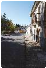
C/ Mecedero. Restos de acequia
