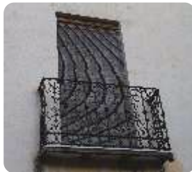
Detalle de la Rejería
